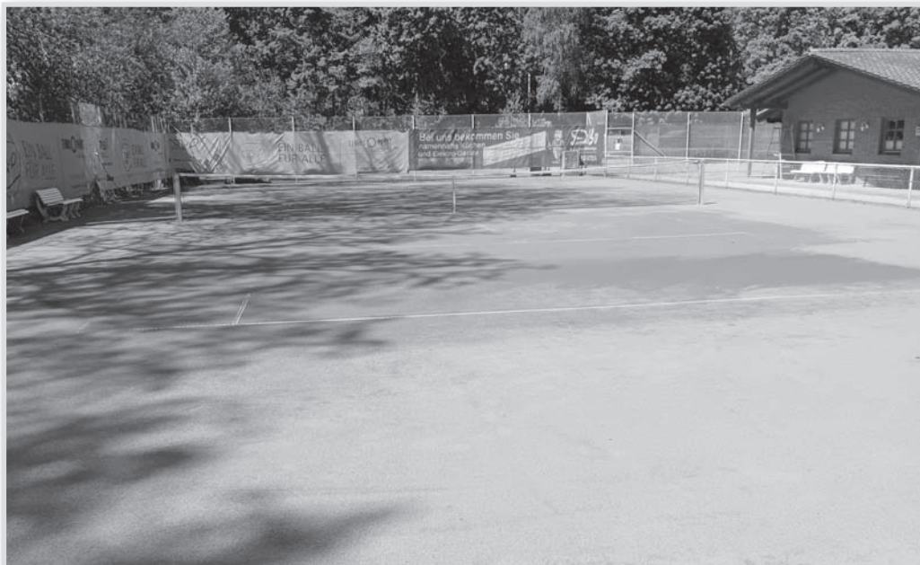
Der Centercourt auf der vereinseigenen Tennisanlage am Schildau-Sportpark präsentiert sich in einem neuen Look. Dieser Platz (1) wurde von der Fachfirma Rathert Sportanlagen, Höxter, von Grund auf saniert.
